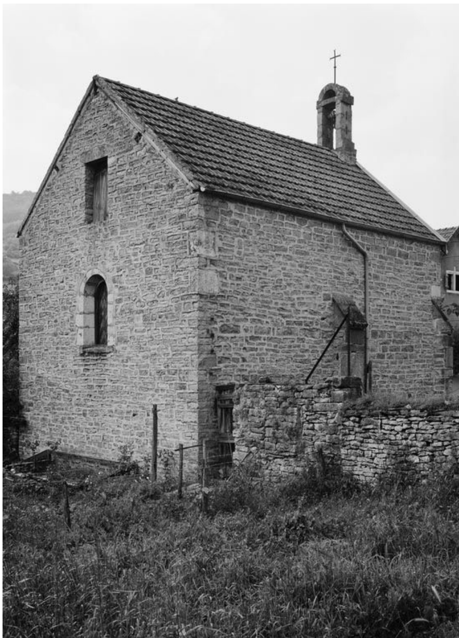
Vue du chevet du mur gauche.
