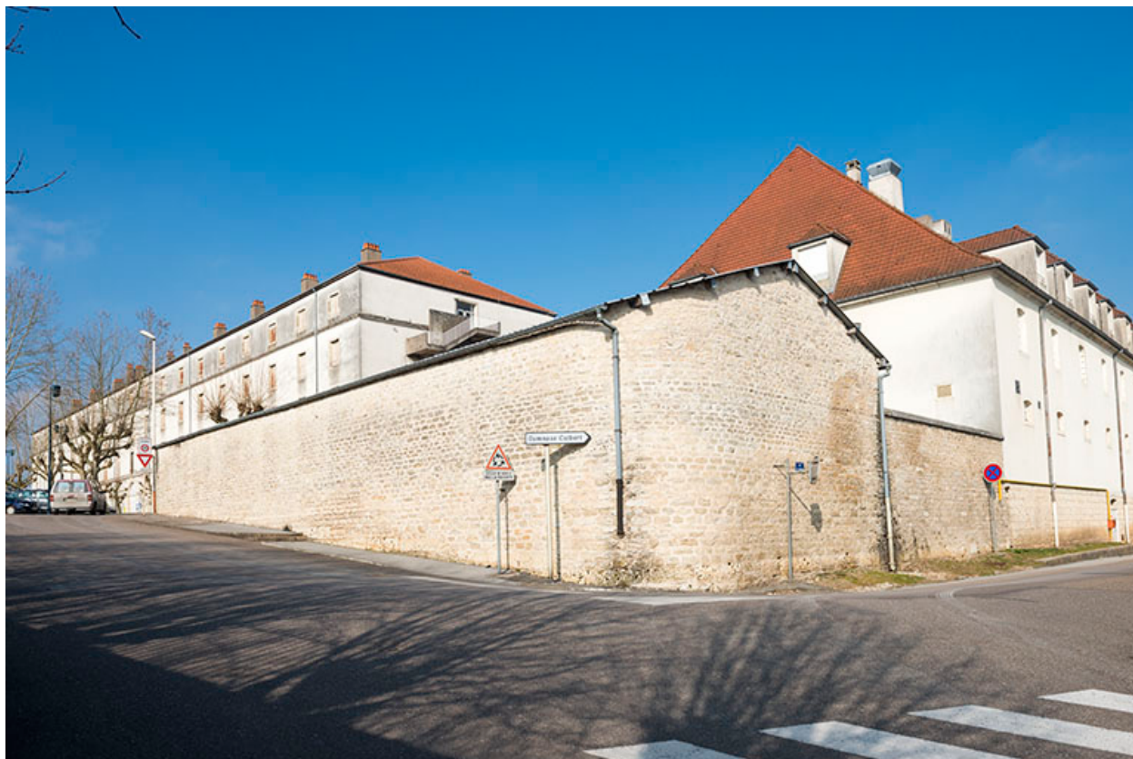
Angle sud-est de l'ancienne caserne.
