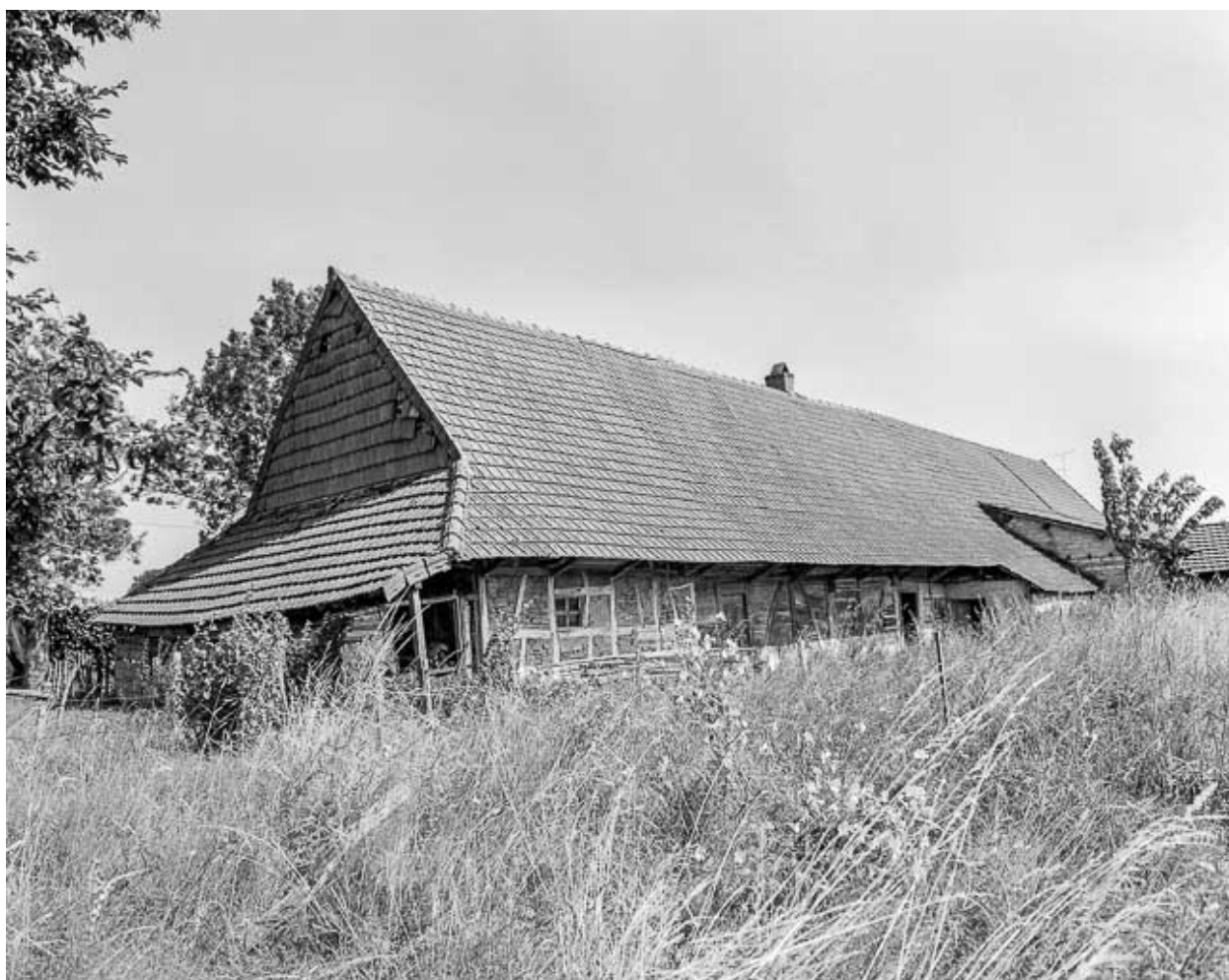
Façade postérieure et côté gauche.
