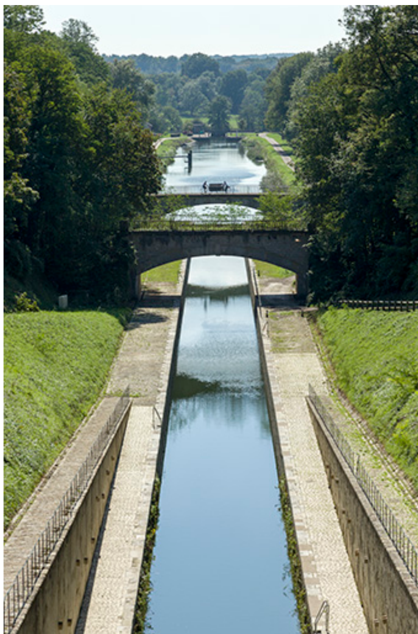
Vue aval, en direction de l'écluse.
