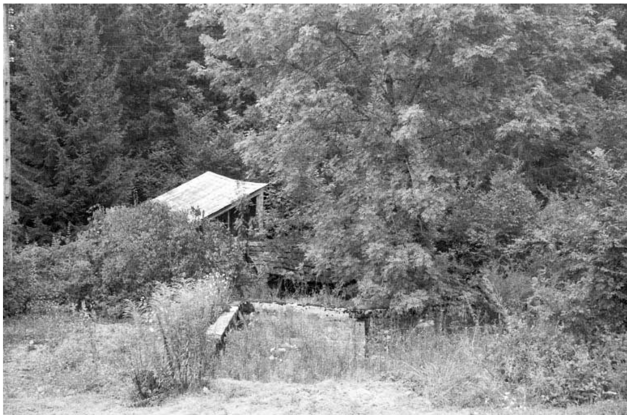
Bassin de retenue et atelier (A).
