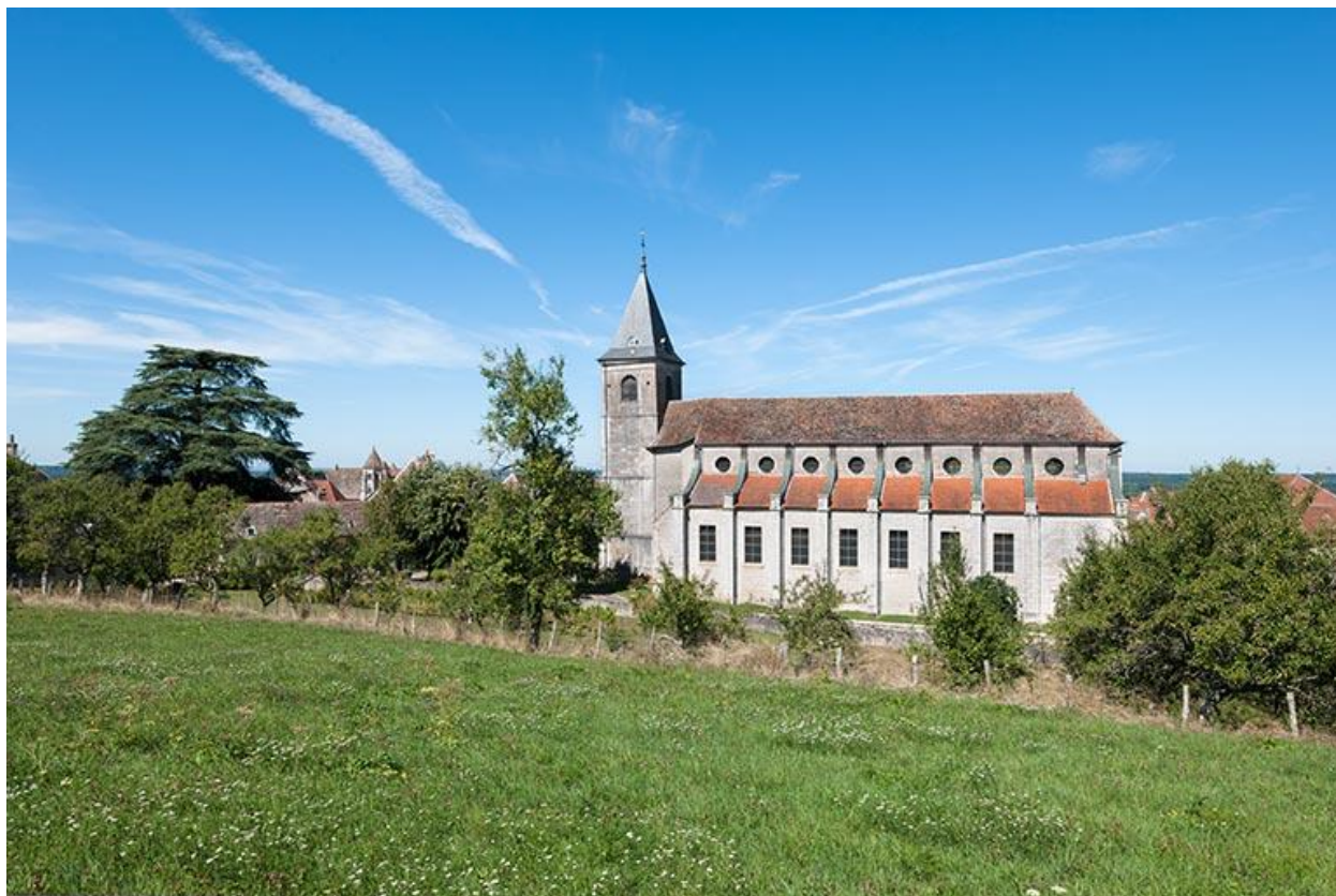
Vue générale sud de l'église
