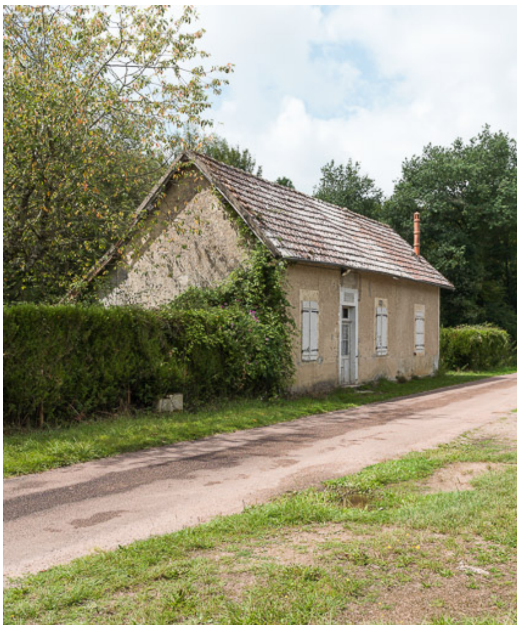
Vue de la maison éclusière.
