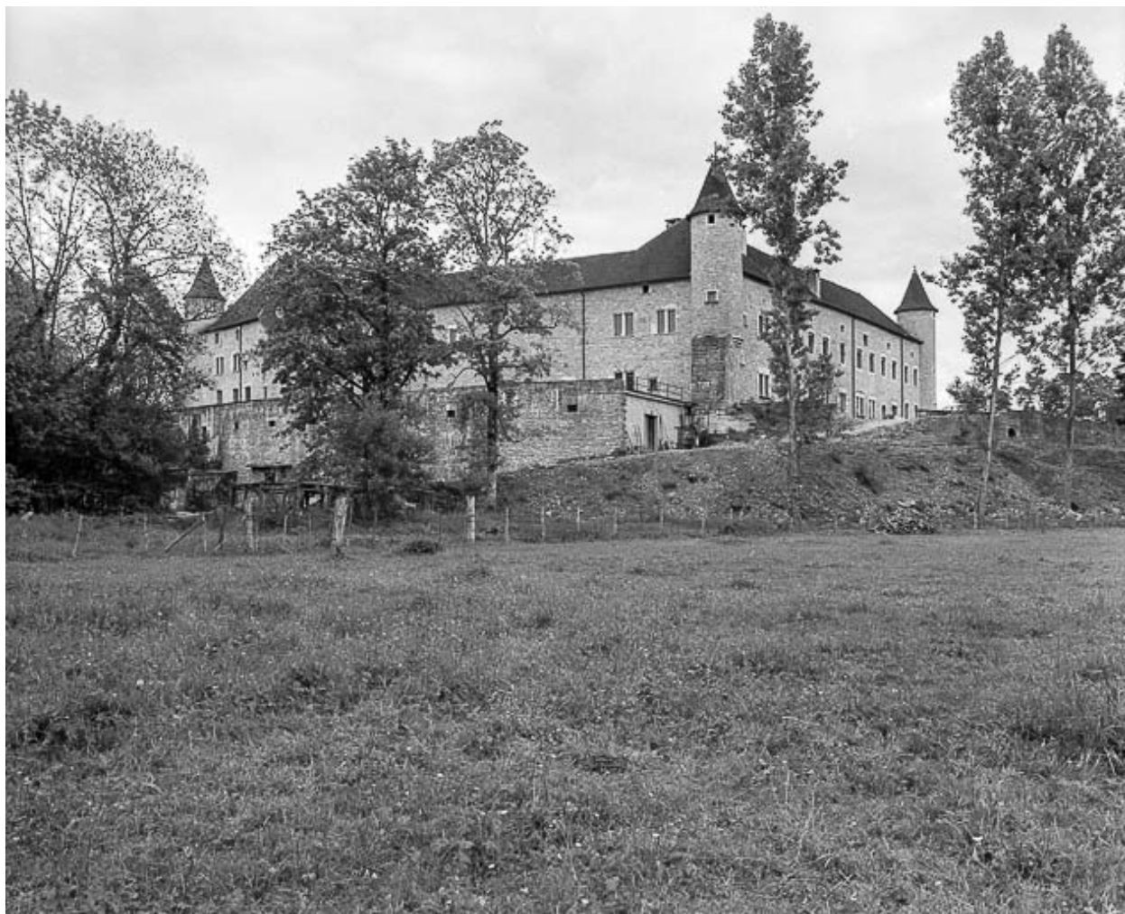
Façades nord et ouest.
