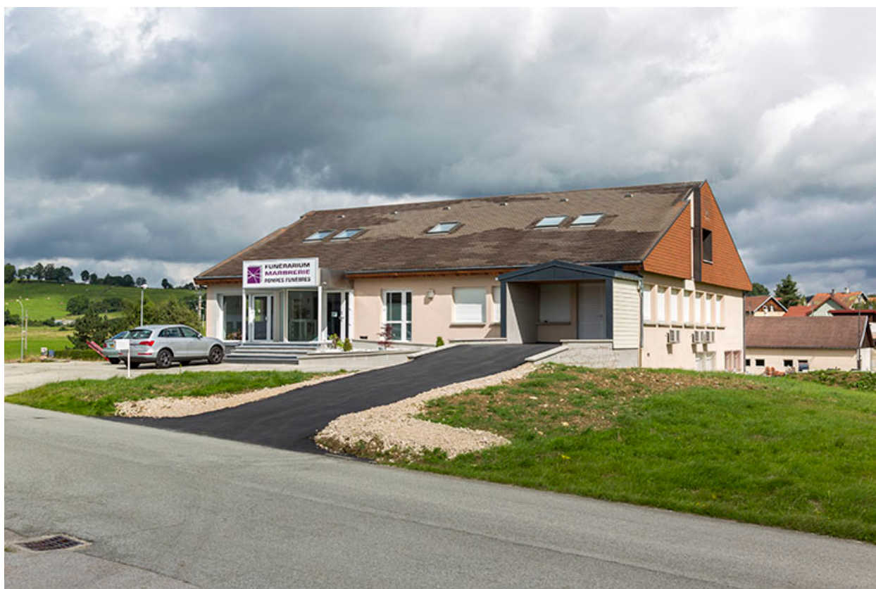
Façades antérieure et latérale droite.
