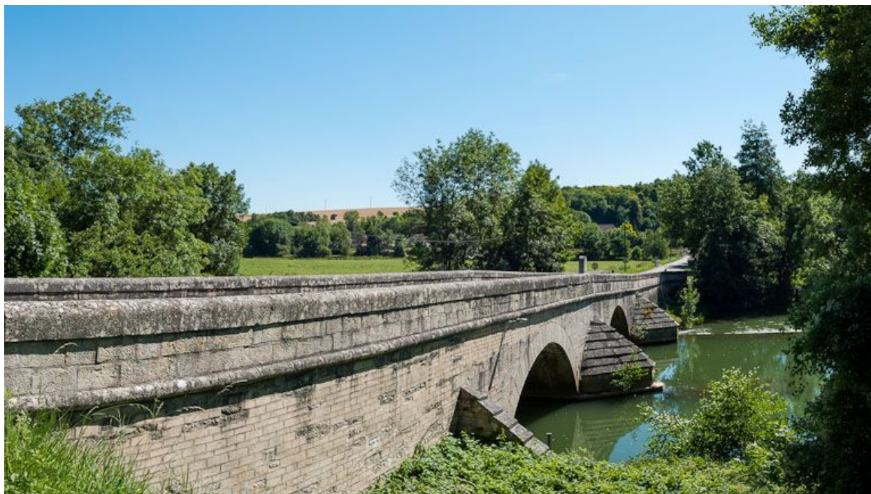
Pont sur l'Armançon.
