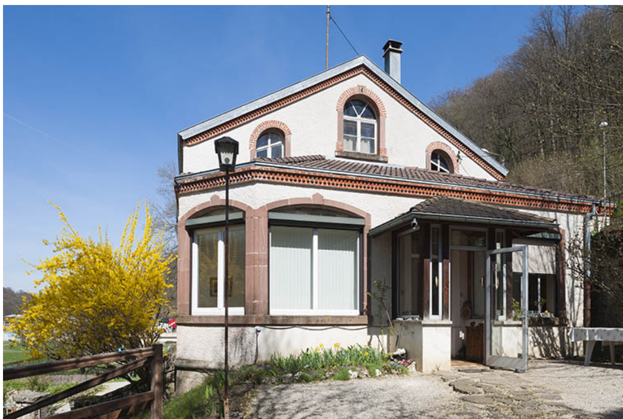
Pignon sud. Vestibule.
