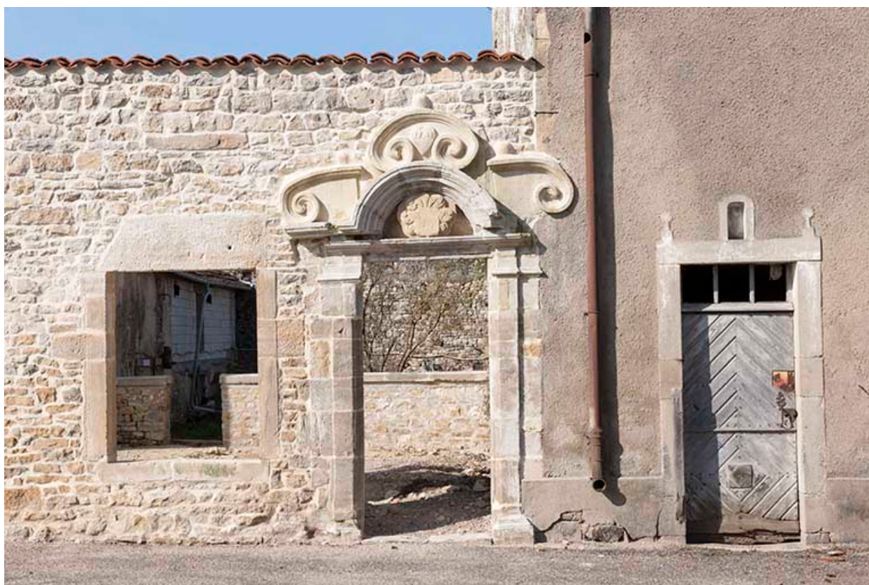
Porte reconstruite avec pierres de remploi.
