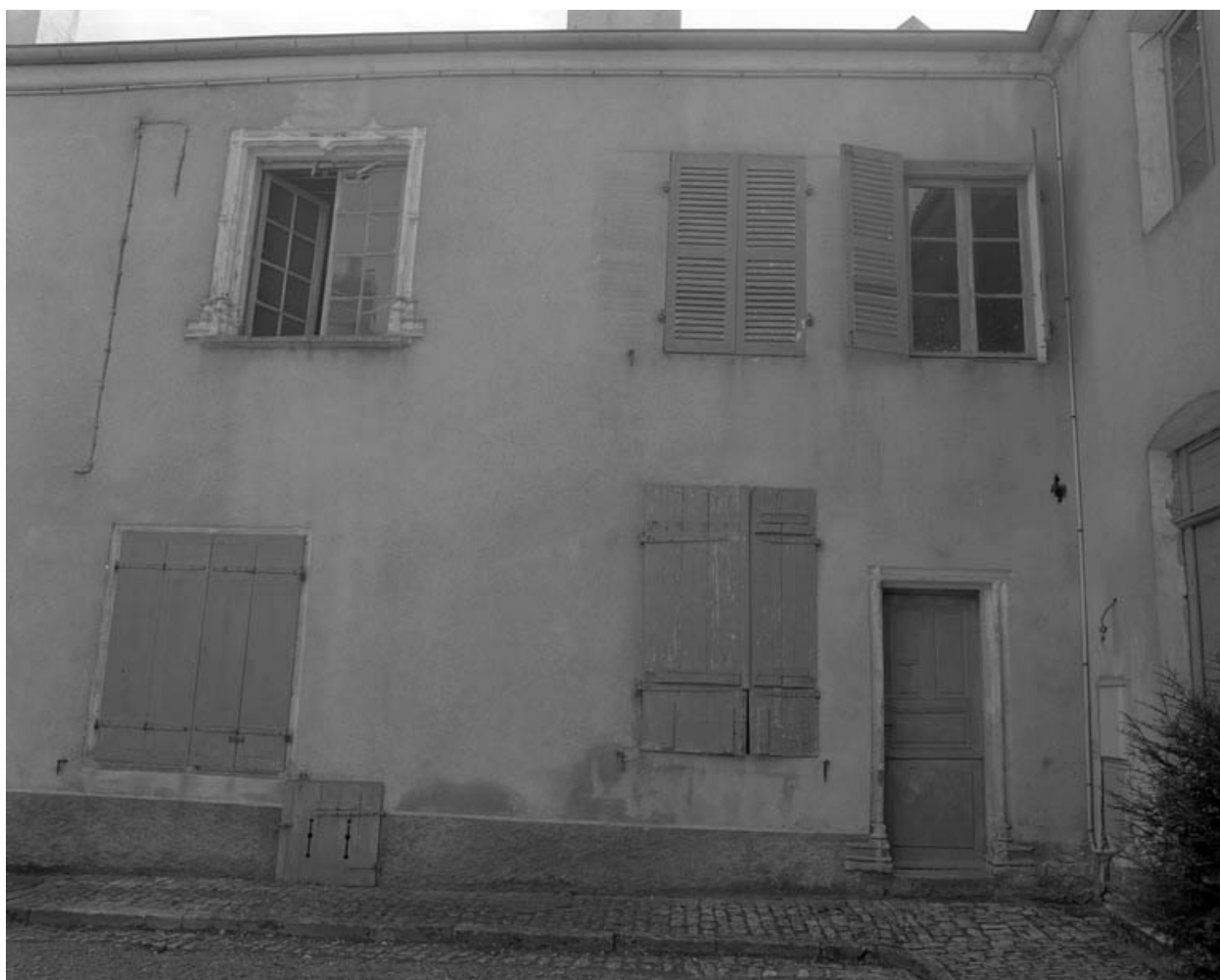
Façade antérieure du logement gauche sur cour.
