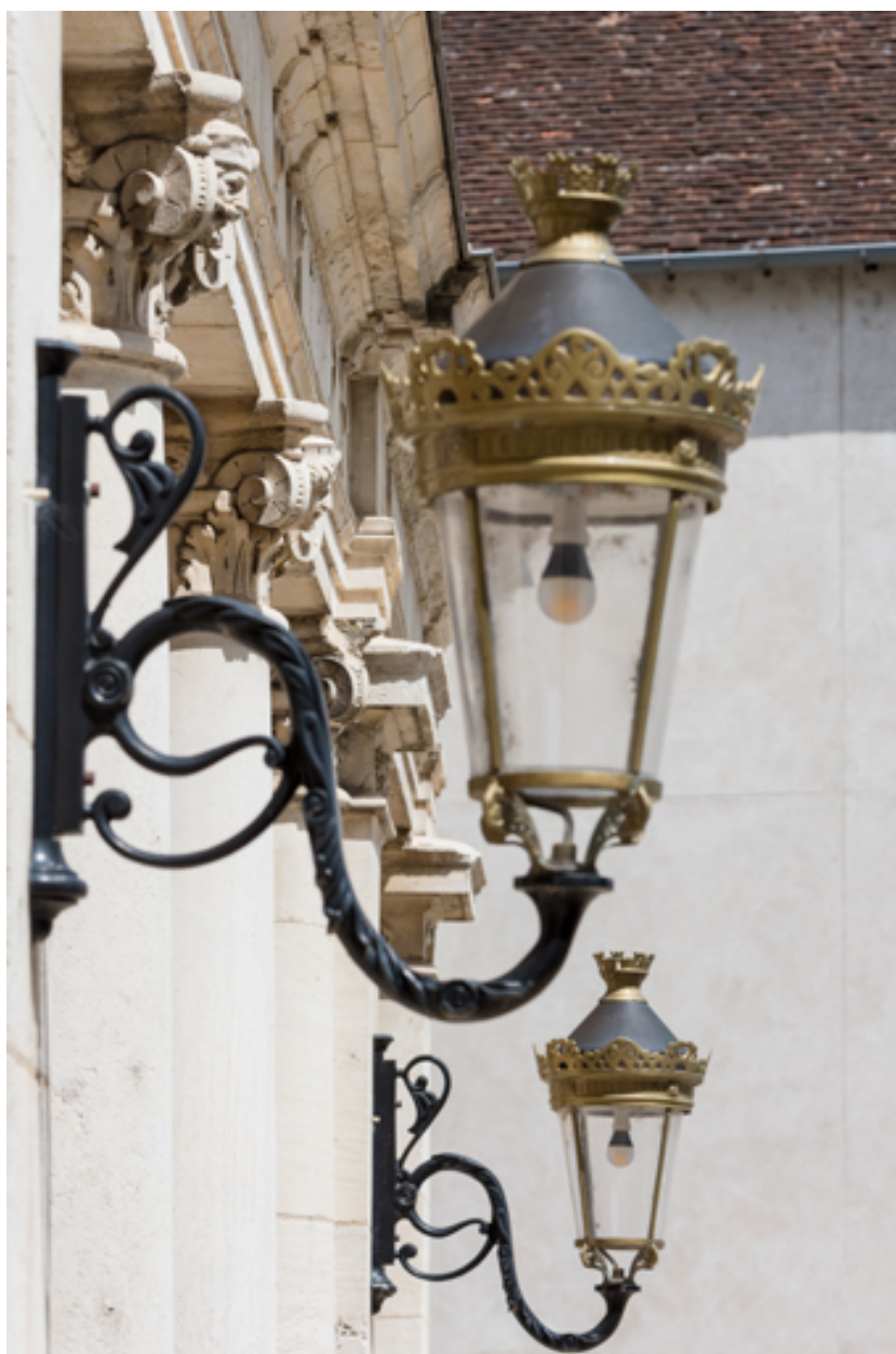
Porche : luminaires d'applique extérieurs.
