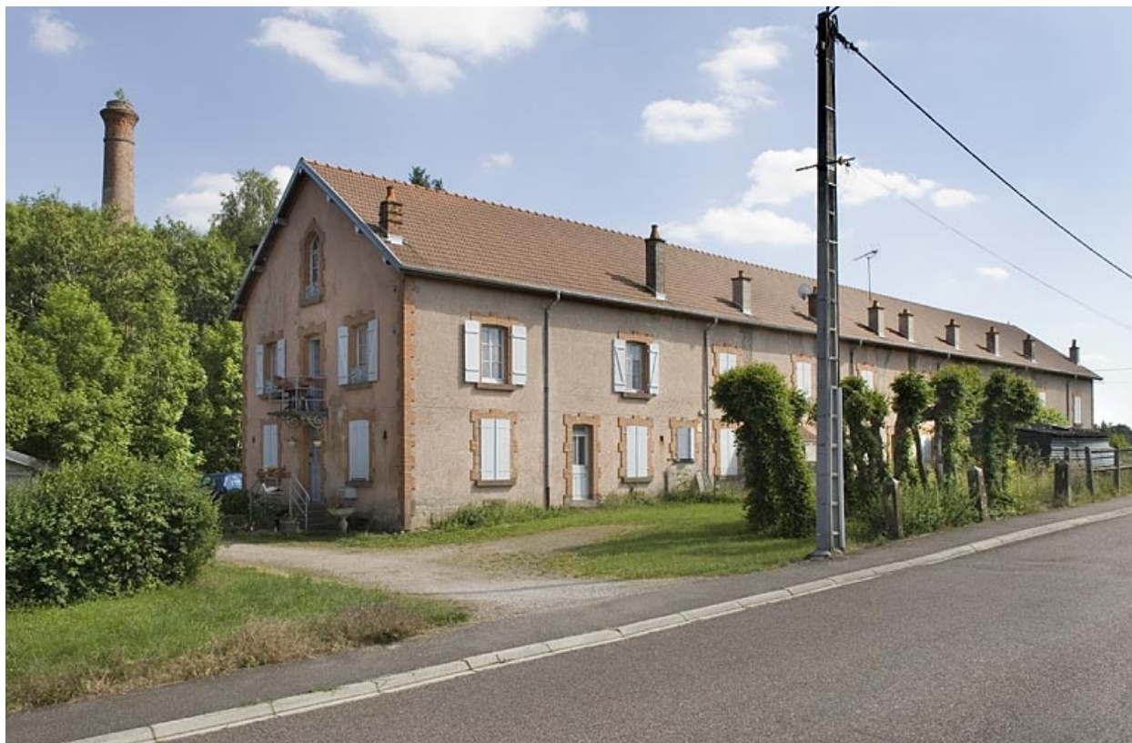
Logement ouvrier dit cité Saint-Anne.
