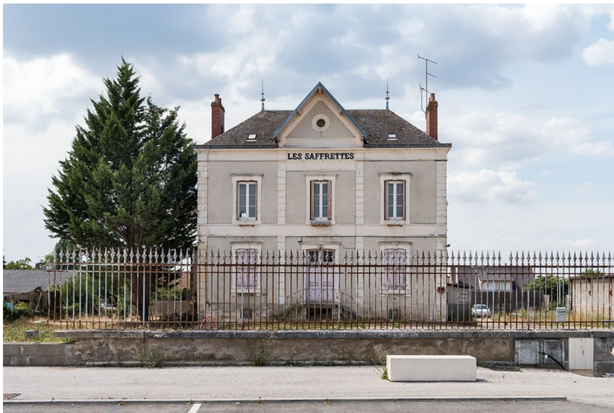
Façade de la maison.
