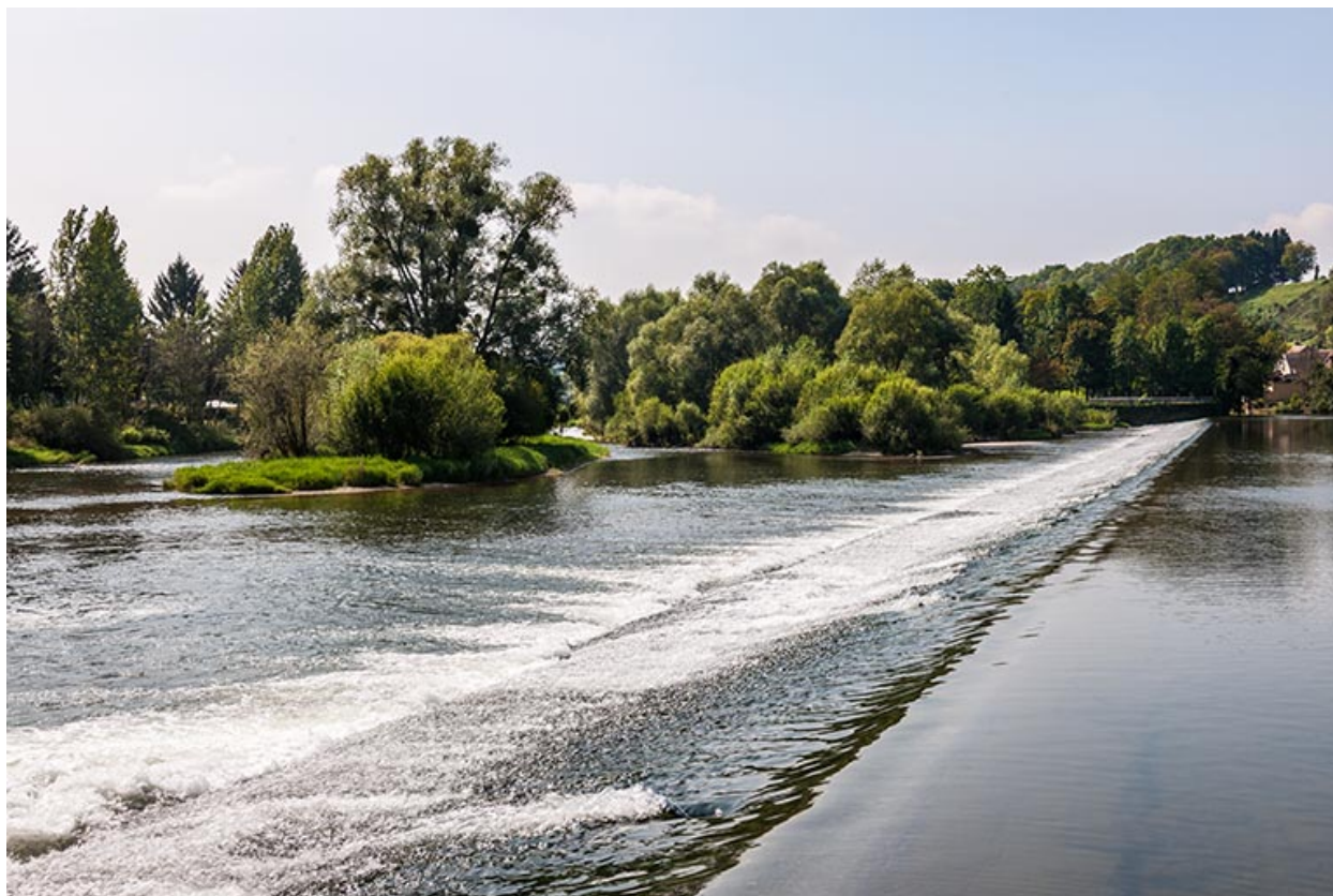
Barrage sur le Doubs.
