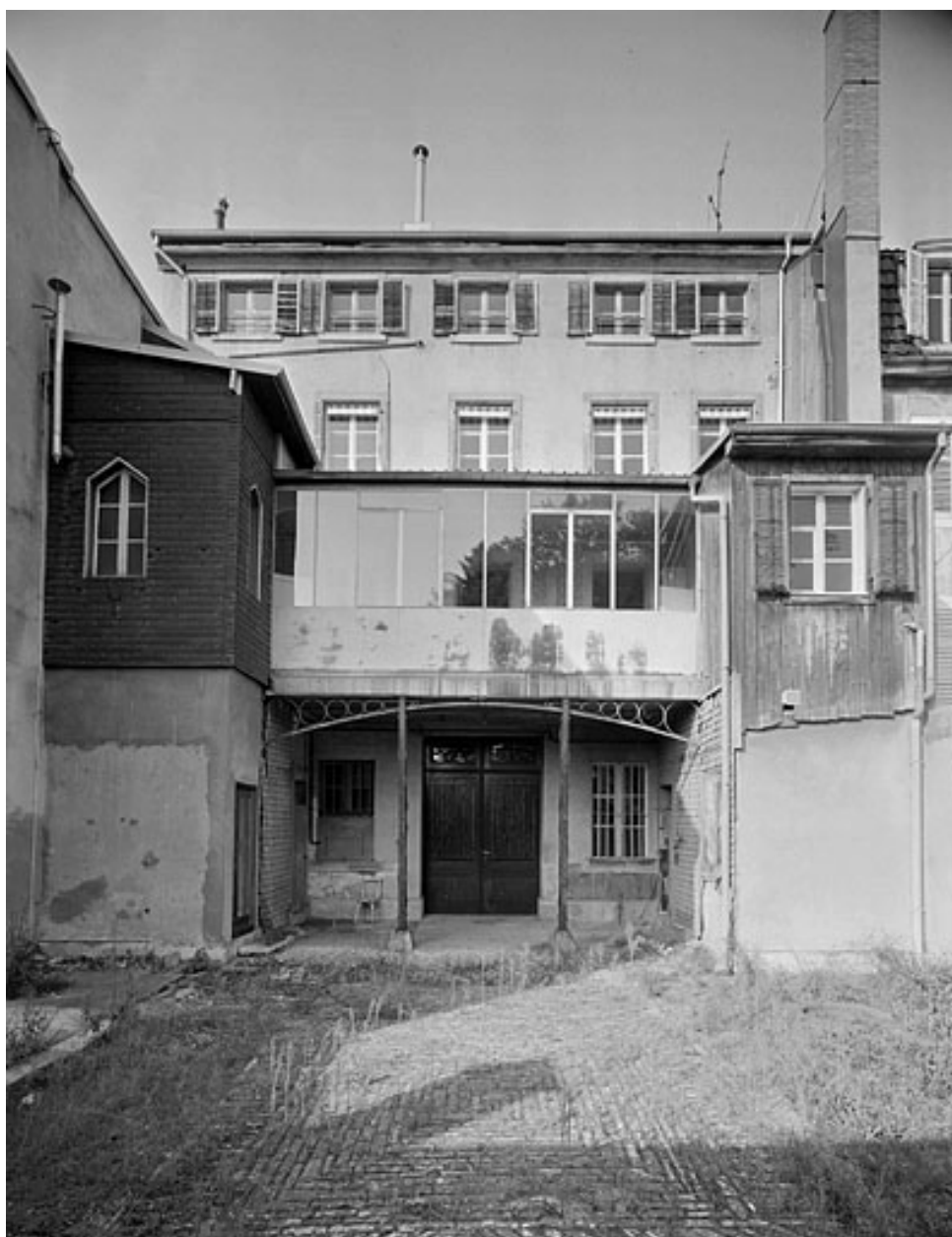
Façade sur cour.
