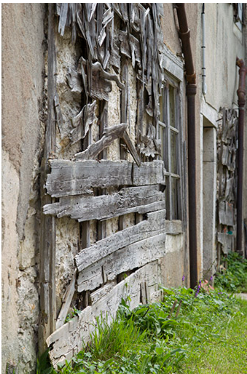
Façade postérieure : support de l'essentage de tavillons, vu en enfilade.
