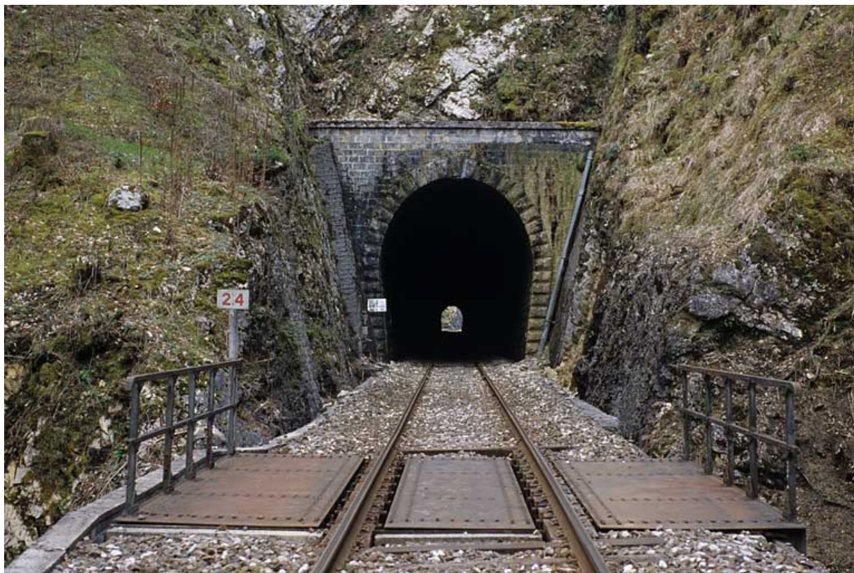
Tunnel : tête côté Andelot-en-Montagne.
