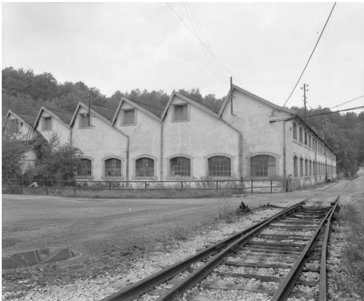
Vue rapprochée de l'atelier des pompes en 1981.
