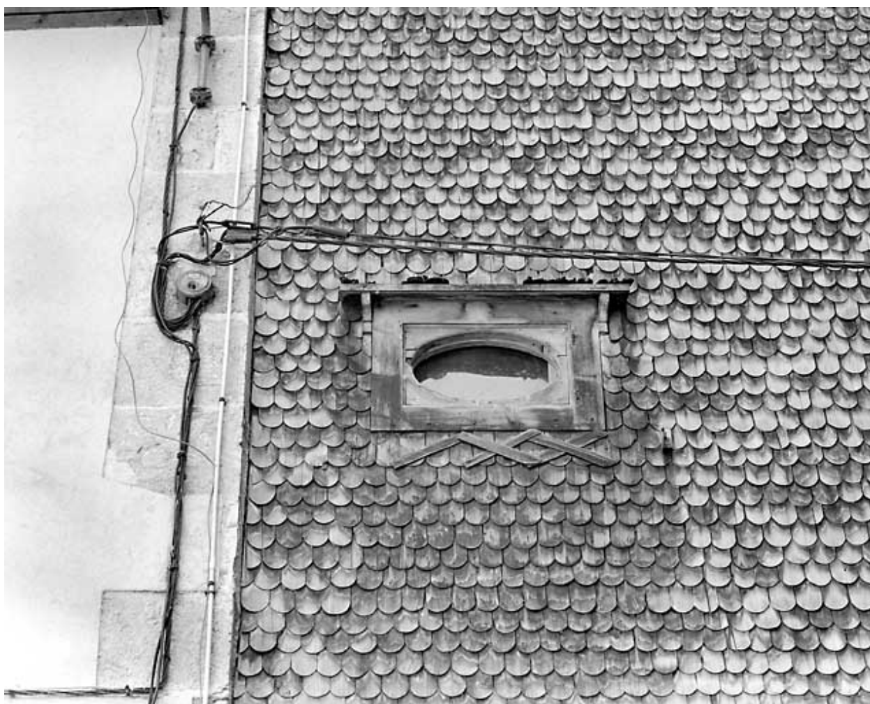
Escalier sud : oculus et tavaillons (bardeaux).
