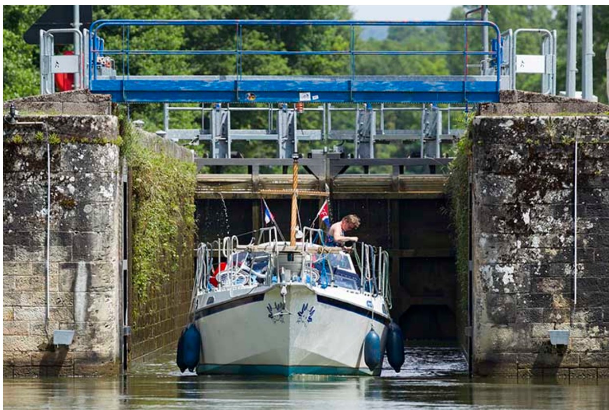
Ecluse n°43, Demangeville (70).
