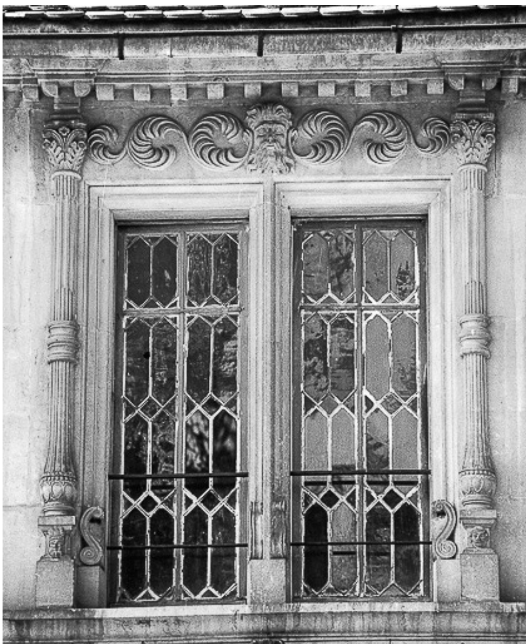
Fenêtre sur rue, à l'étage.
