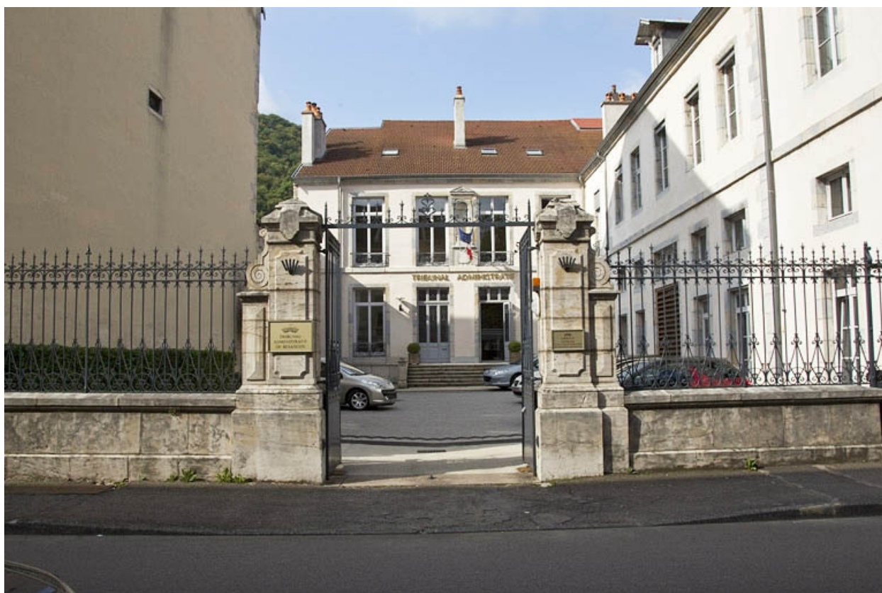
Vue d'ensemble, de face, depuis la rue.
