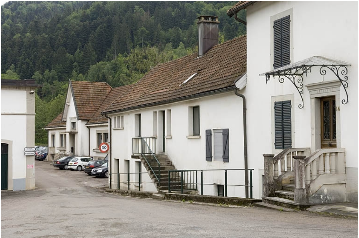
Les bureaux vus depuis l'entrée.
