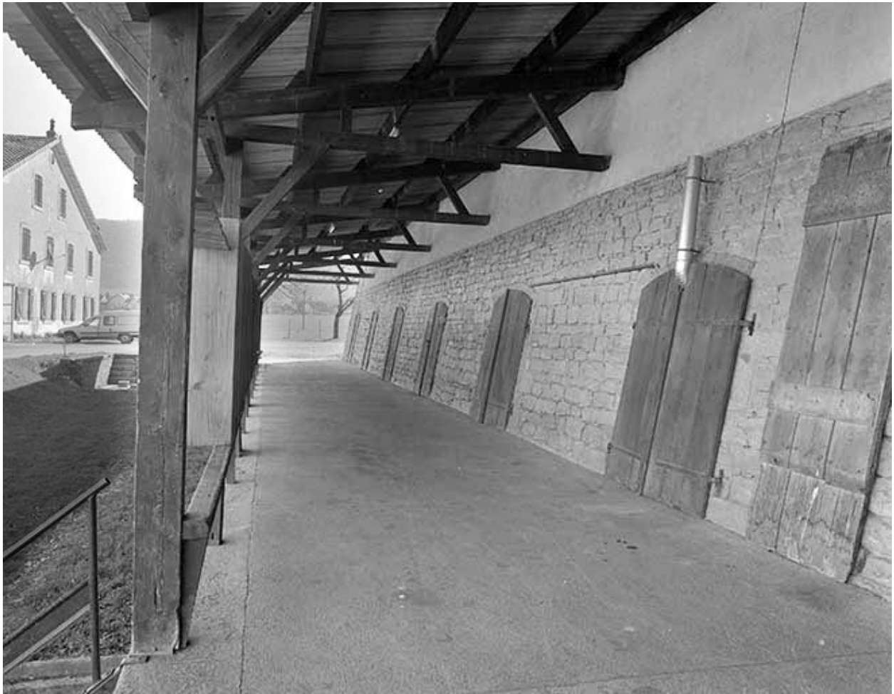
Saline de Poligny : portes du magasin industriel.
