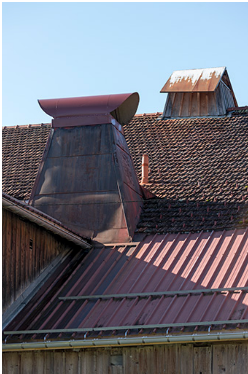
Pan de toiture nord, avec deux "tués".
