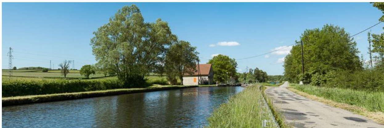
Vue d'ensemble du site, prise d'amont.
