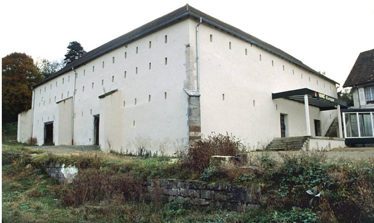
Ancienne halle à charbon depuis le nord-ouest.
