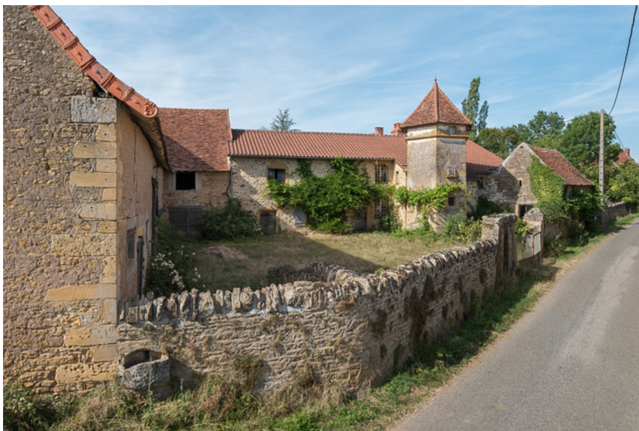
Vue d'ensemble des bâtiments du domaine
