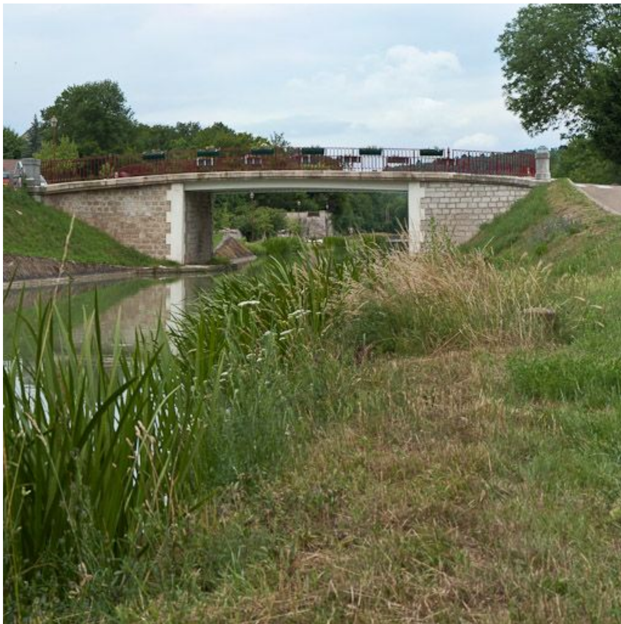
Vue du pont depuis l'aval.
