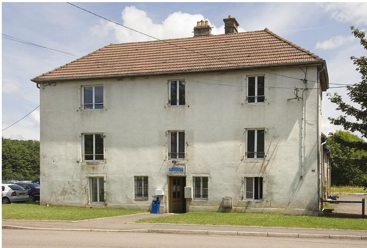
Bâtiment des commis. Façade ouest.
