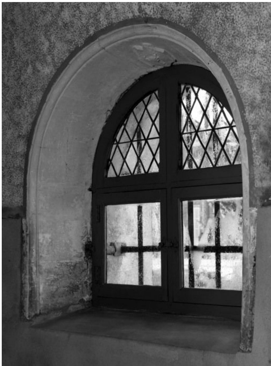
Sacristie, mur gauche, fenêtre
