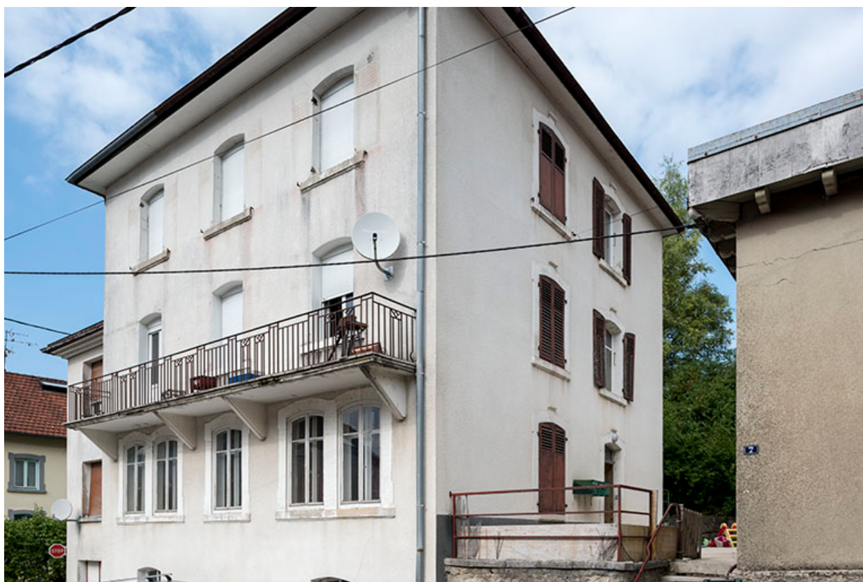
Maison : façades antérieure et latérale droite.
