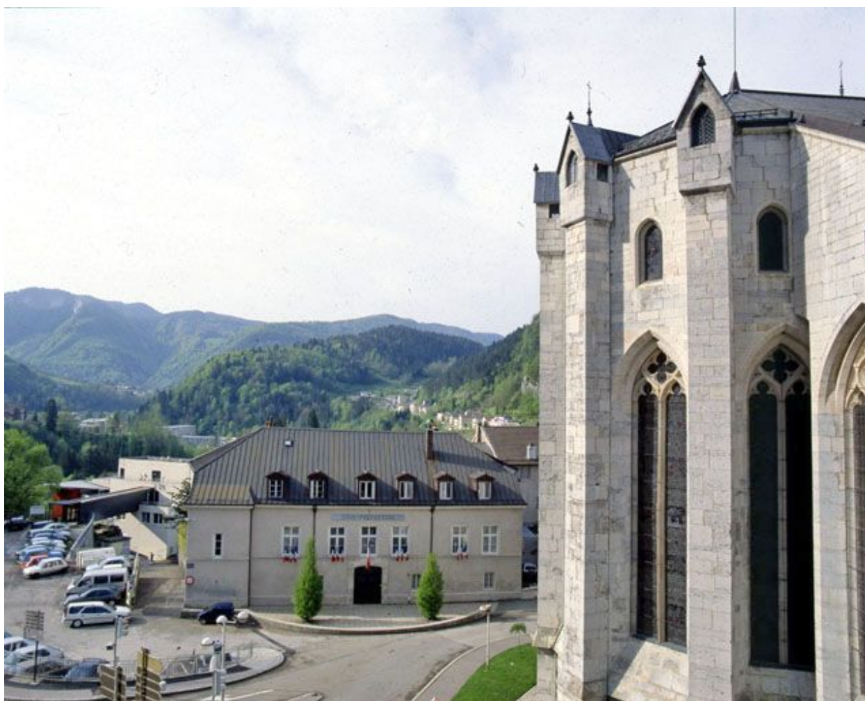
Façade sur rue vue depuis la cathédrale.
