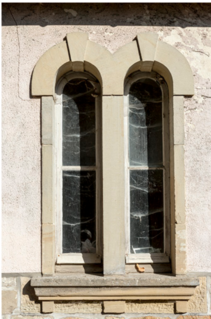
Détail des baies jumelées de l'ancienne dépendance.
