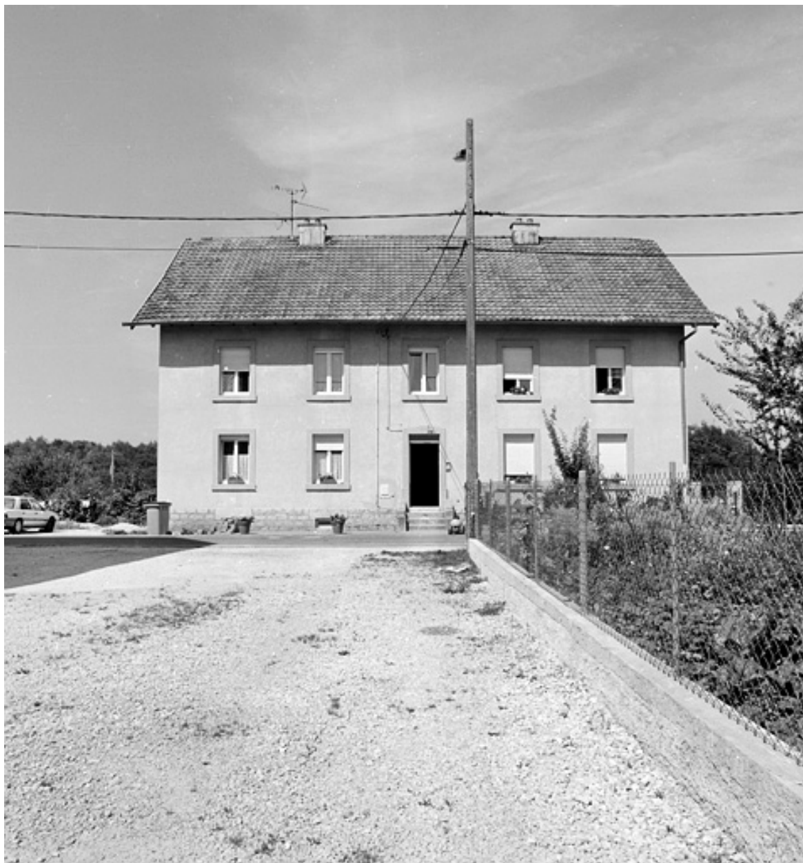
Vue d'ensemble d'un logement ouvrier collectif.
