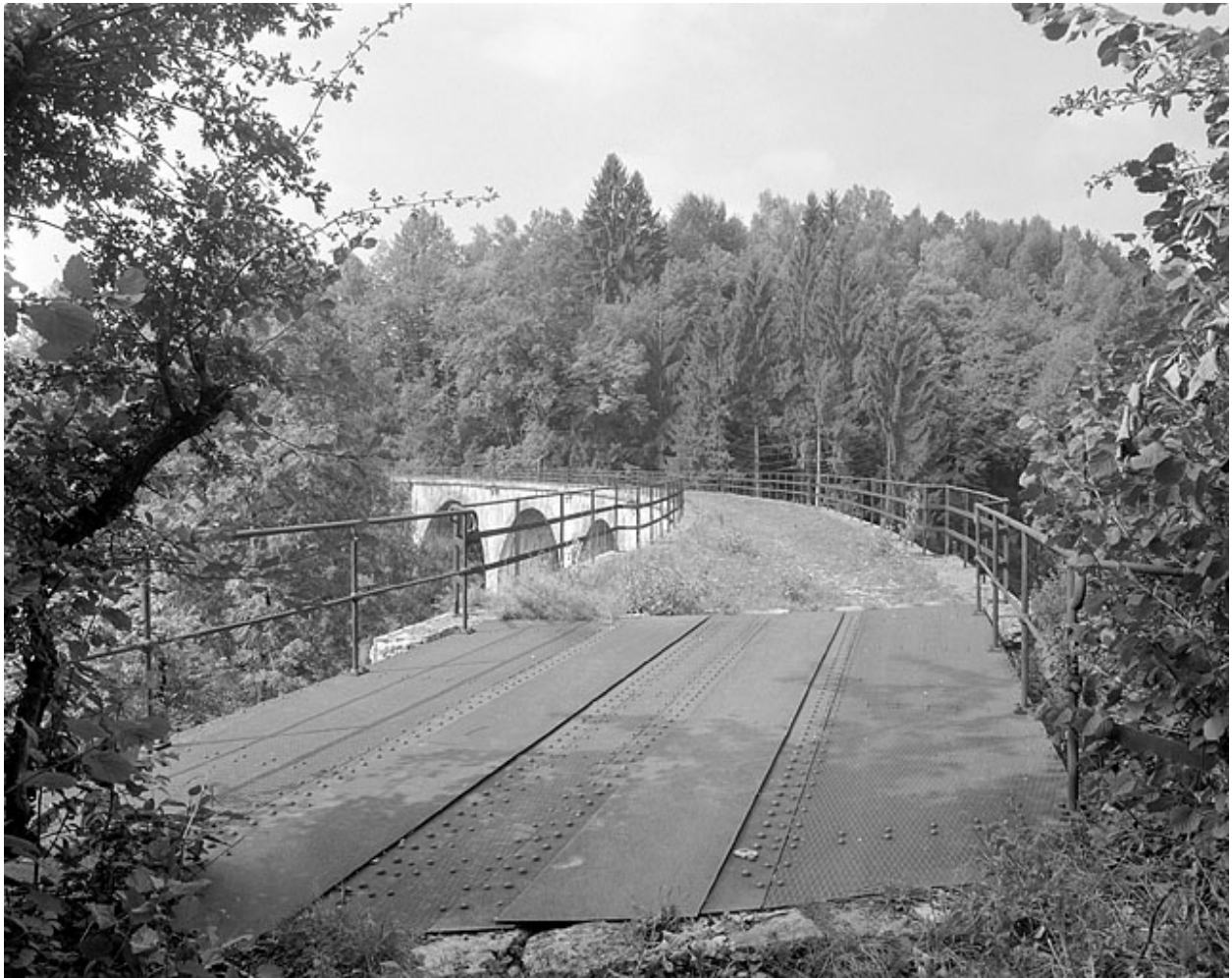
Tablier du viaduc.
