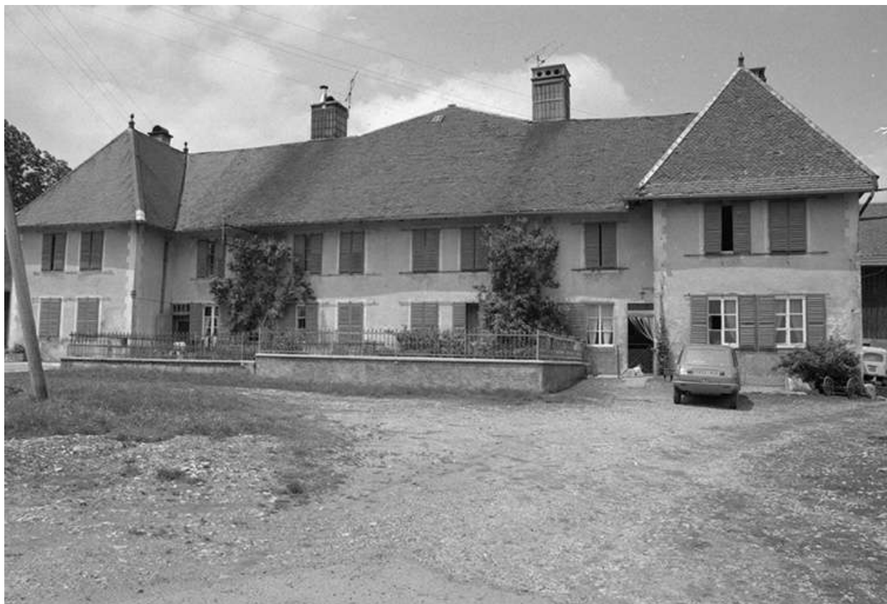
Ferme située 1 Grande Rue : façade antérieure.
