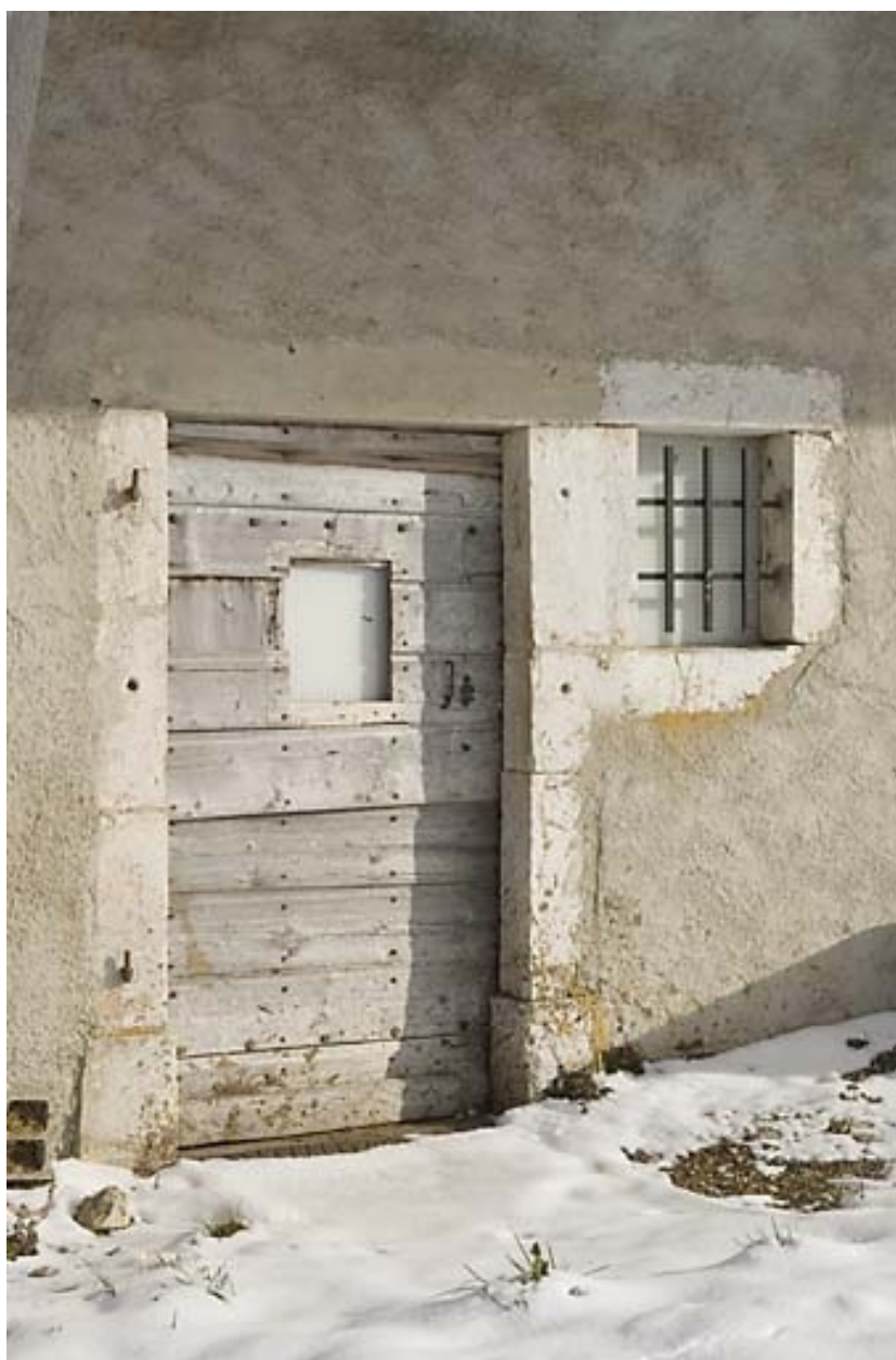
Façade antérieure : porte d'étable.
