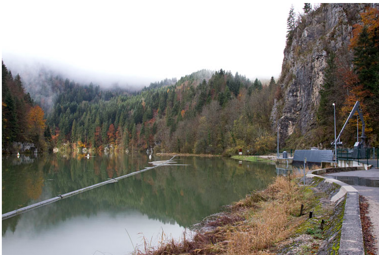
Bassin de retenue et ouvrage de prise d'eau.
