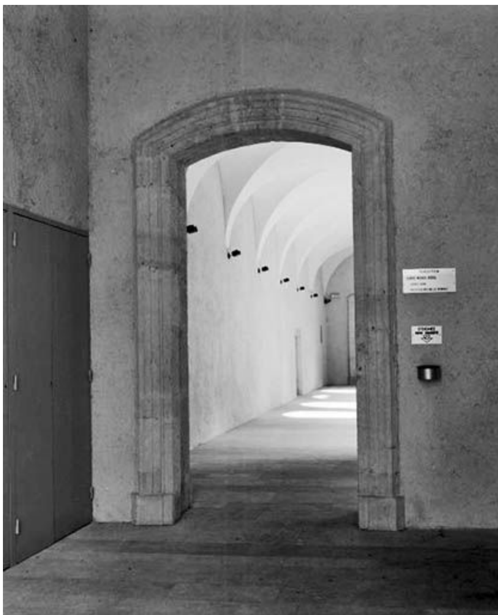
Intérieur : porte conduisant au cloître.
