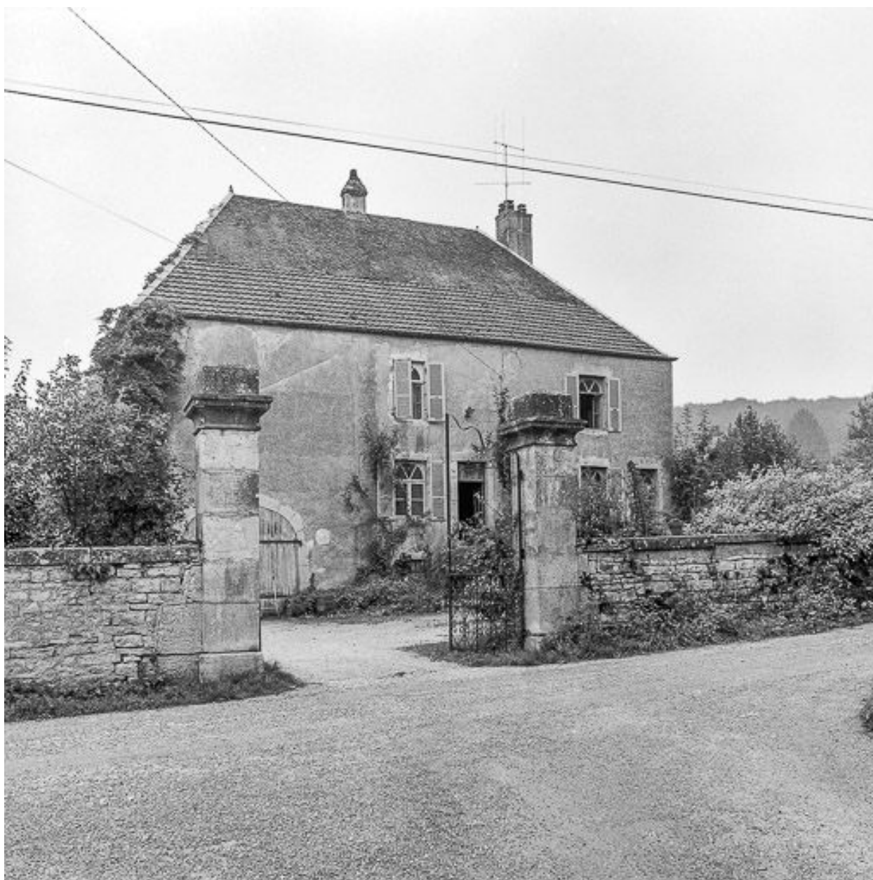
Vue de la partie habitation.
