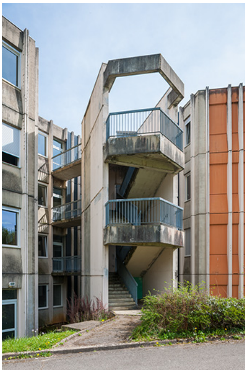
Détail de l'escalier extérieur de l'internat.
