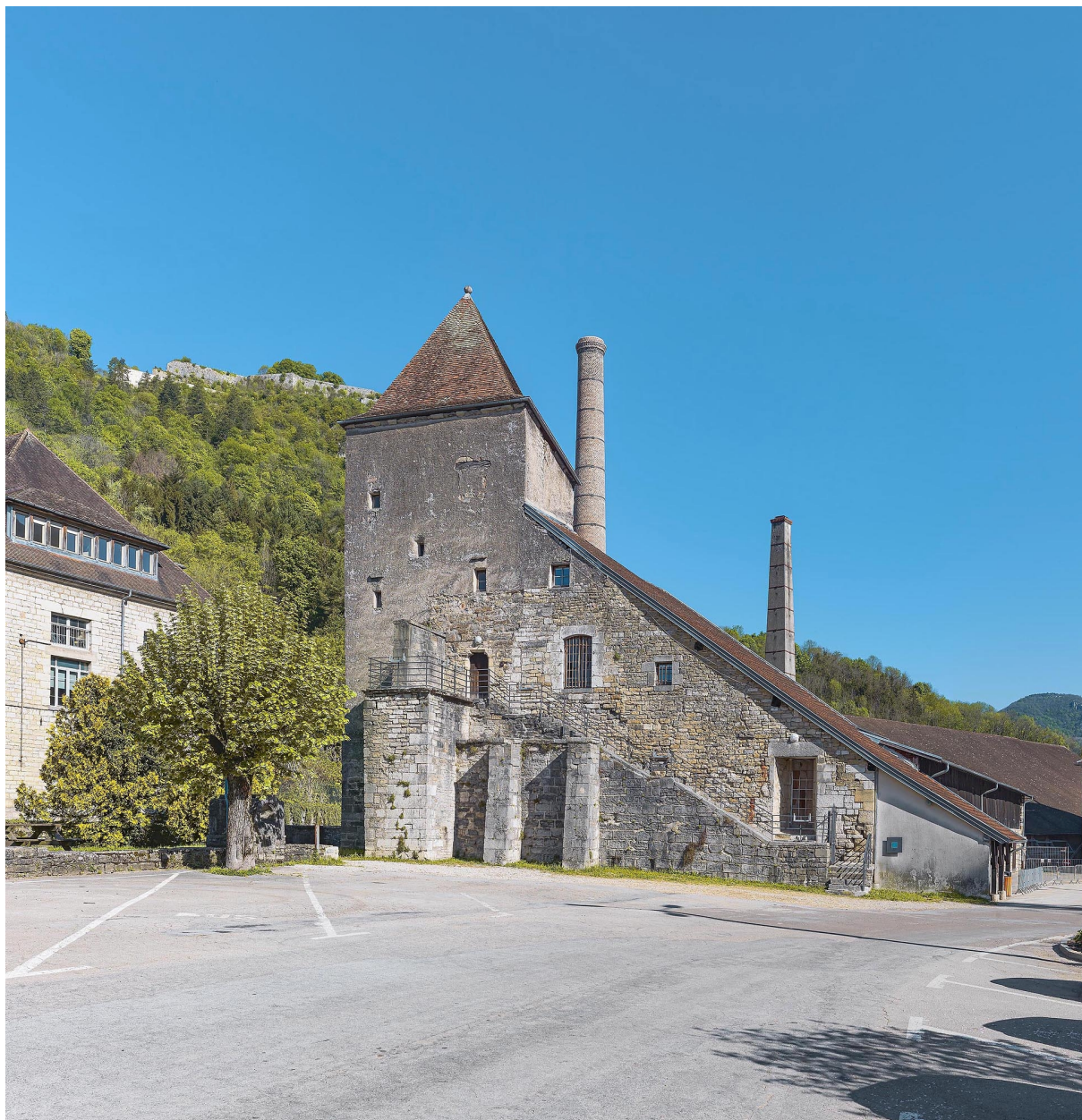
La tour de Reculot et le bâtiment des poêles, depuis le sud.
