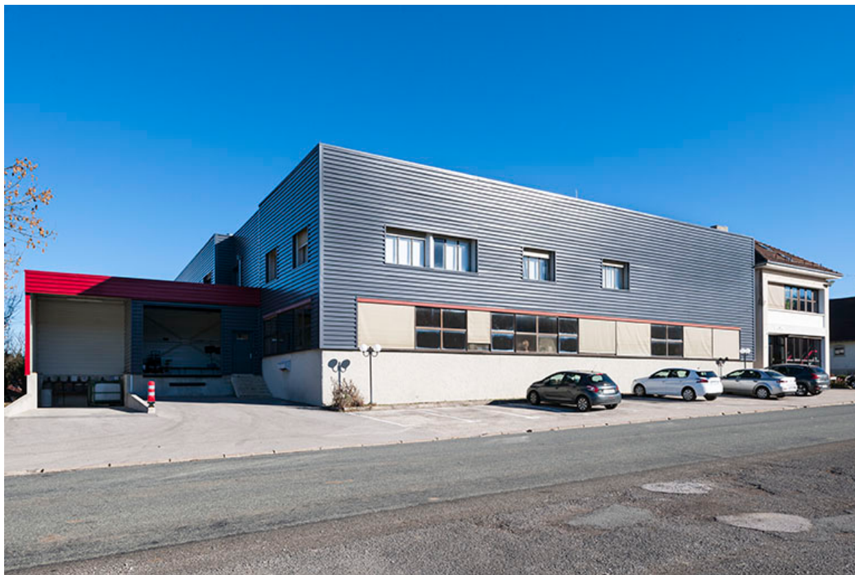
Façade antérieure : ateliers ouest.
