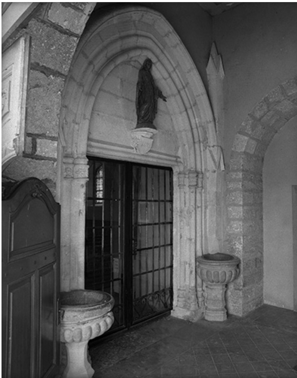
Portail d'entrée depuis la nef.
