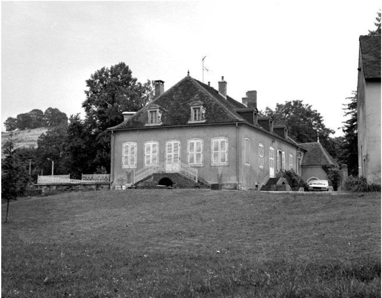
Façade droite du logis.
