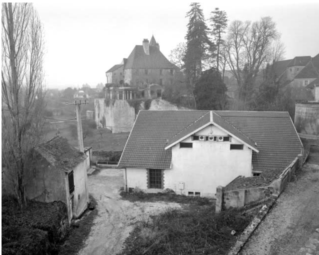
Vue plongeante sur la centrale.
